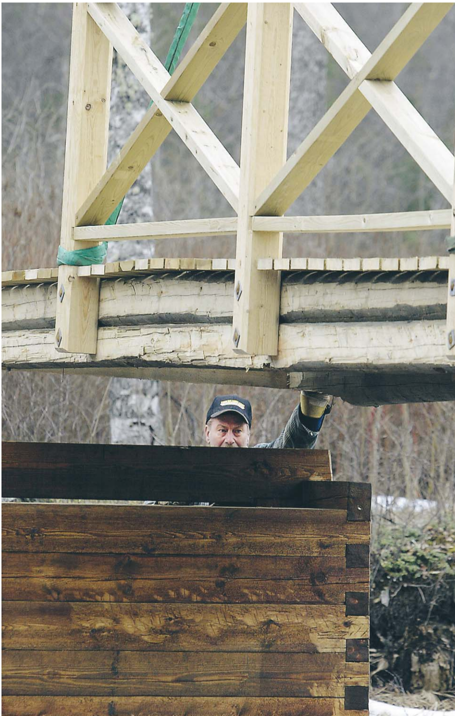
Roland Andersson riktar in brodelen så att den kommer rätt mot fundamentet.
