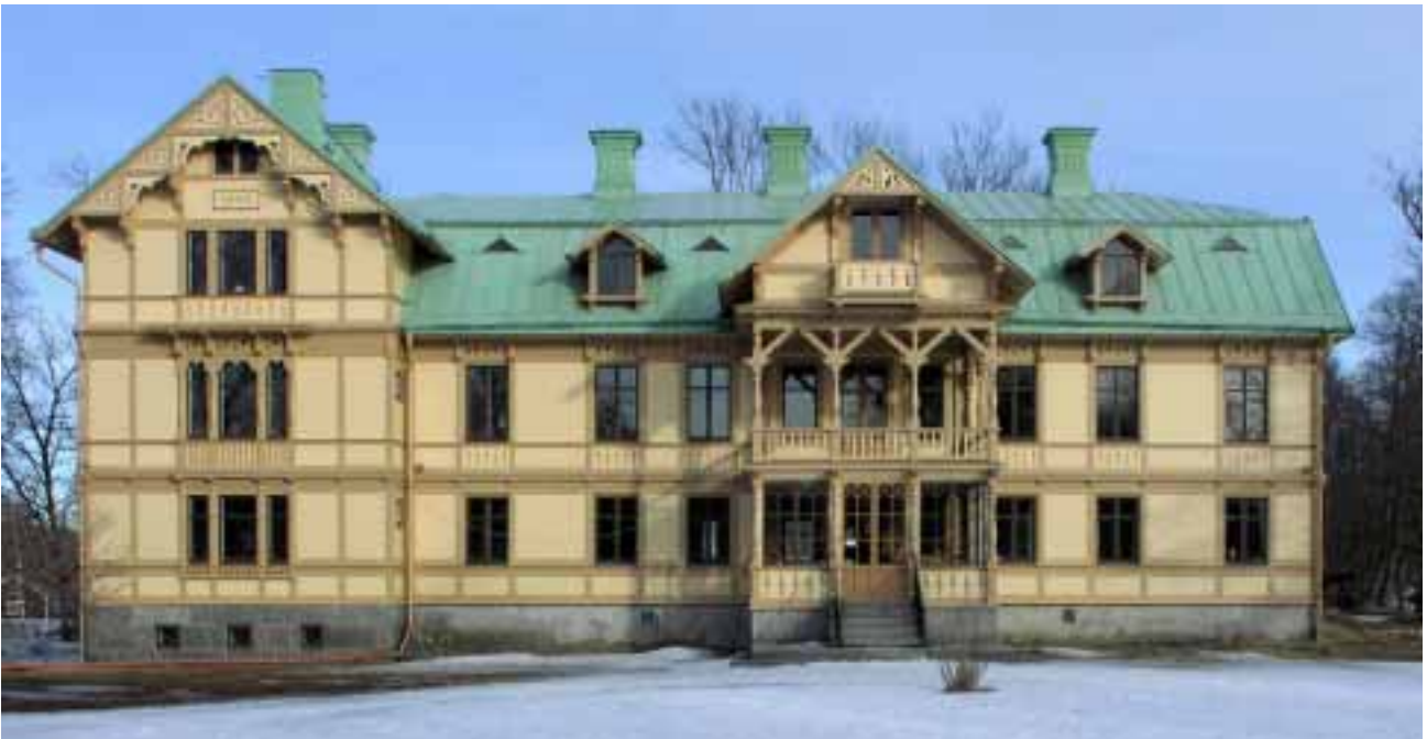
Taket är sedan några år omlagt med fabrikslackerad bandplåt. Ett långt plåtband ersätter alltså en rad av hopfalsade plåtar ovanför varann. Bandens bredd är något större än hos den ursprungliga plåten.
