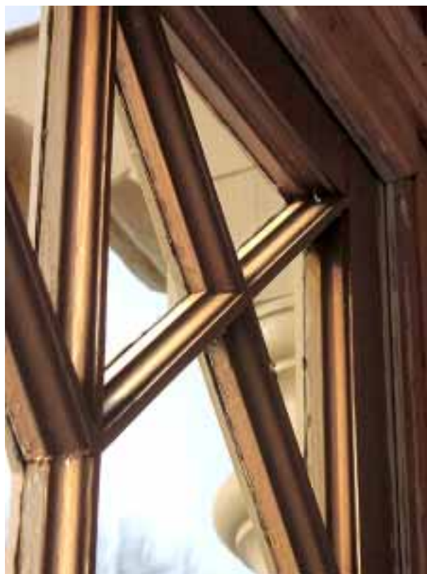
De flesta fönster i huset byttes ut på 1950-60-talen, men verandans ytterdörr från 1891 är bevarad, med ursprungliga tidstypiska spröjsprofiler.
