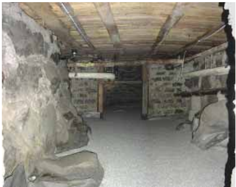
Rum 013, vy mot 012. T v hjärtmur av gråsten, i fonden mellanvägg av slaggtegel, t h östra grundmuren av gråsten.
