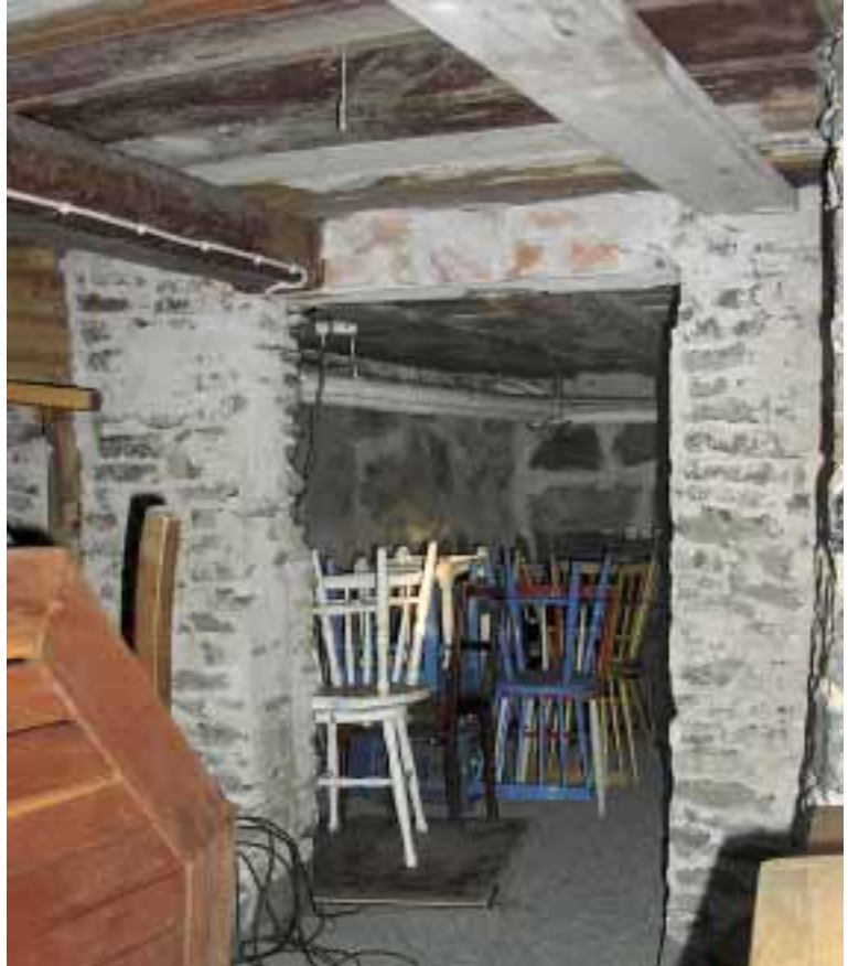
Rum 001, innanför dörren mot rum 002. I taket ses återanvända gamla golvbräder.
