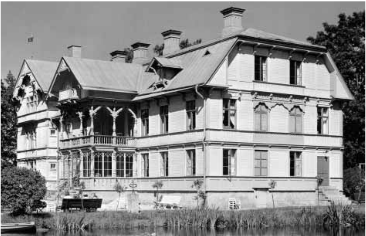
Vy från 1955. På tillbyggnaden är en ursprunglig vindflöjel bevarad, medan en skorsten är moderniserad sedan centralvärme infördes. Dessutom har små fönster tagits upp till de två nya badrummen i tillbyggnaden. På verandan har en prydnad på gavelspetsen försvunnit. Takplåten, med hakfalsar i linje, är bevarad, medan stuprören är nygjorda. Färgsättningen är rejält förenklad. Foto Nordiska museet.
