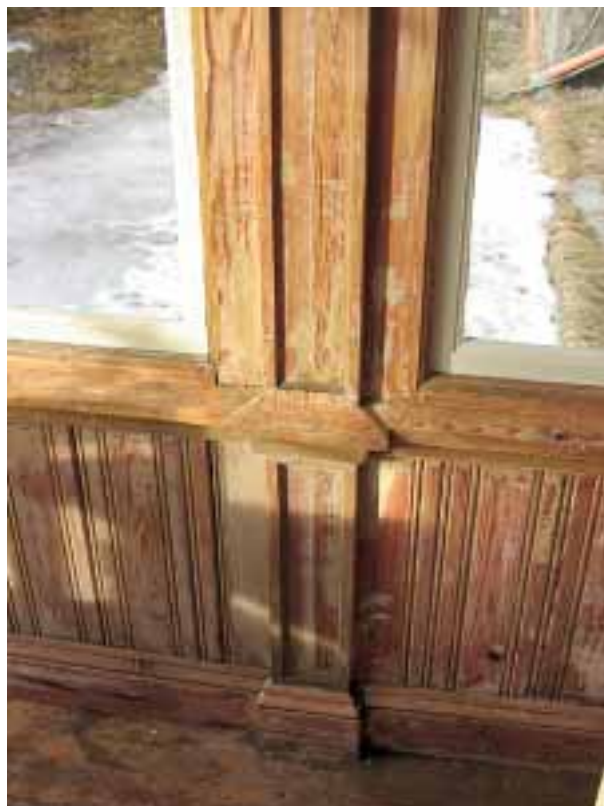
Verandans stolpar är utformade som pilastrar med försänkta speglar och andra detaljer. Spontpanelen i bröstningen har en ovanlig profilering. Golvet har spår av ekådring, antagligen var det målat redan 1891.
